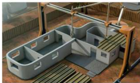
Рис. 2.14. Применение 3D-принтеров в строительстве
