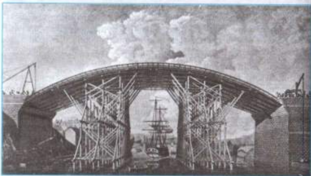
Мост на реке Уир, около Сандерленда, построенный в 1796 г. В Англии с последних лет XVIII в. железо начинает замещать дерево
