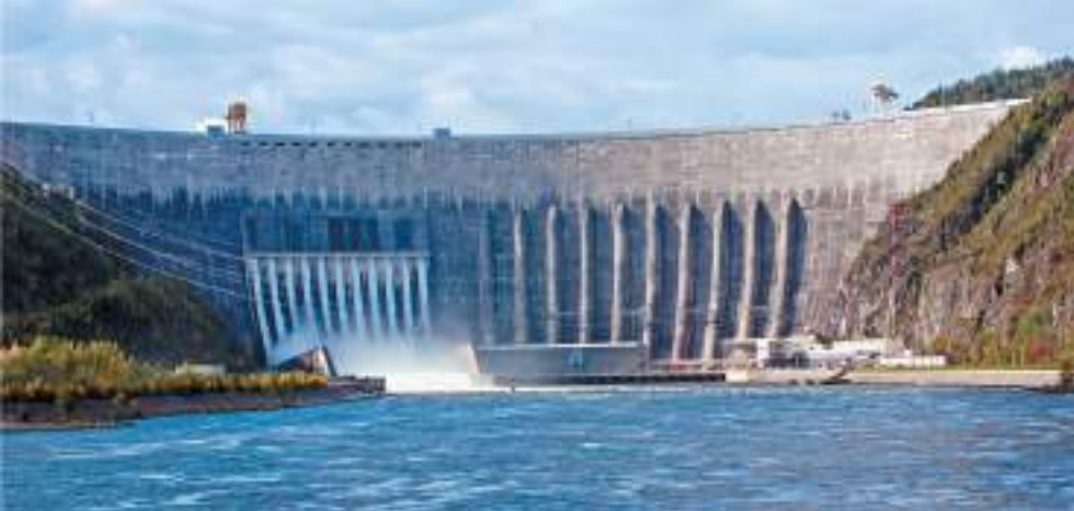
Рис. 8. Плотина Саяно-Шушенской ГЭС
