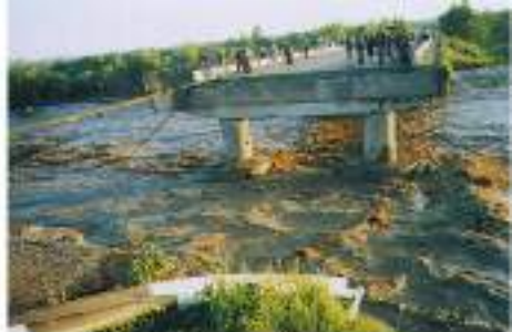
Рис. 68. Разрушенные в результате ливневых дождей мост и дорога в Ставропольском крае
