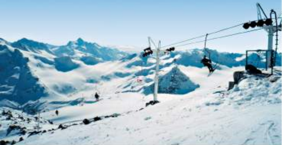
Рис. 79. Канатная дорога на горнолыжной базе в Приэльбрусье
