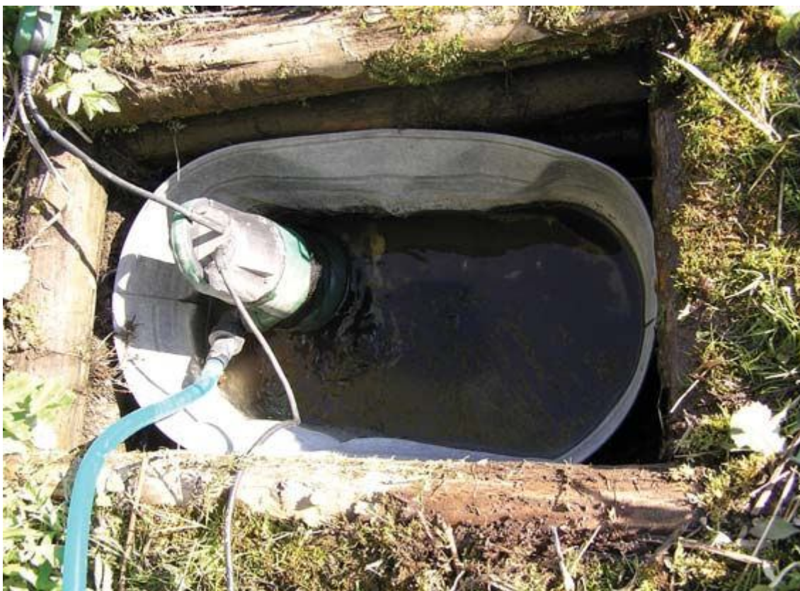
Рис. 3.12. Опалубка водозабора и дренажный насос Marina SLG-400
