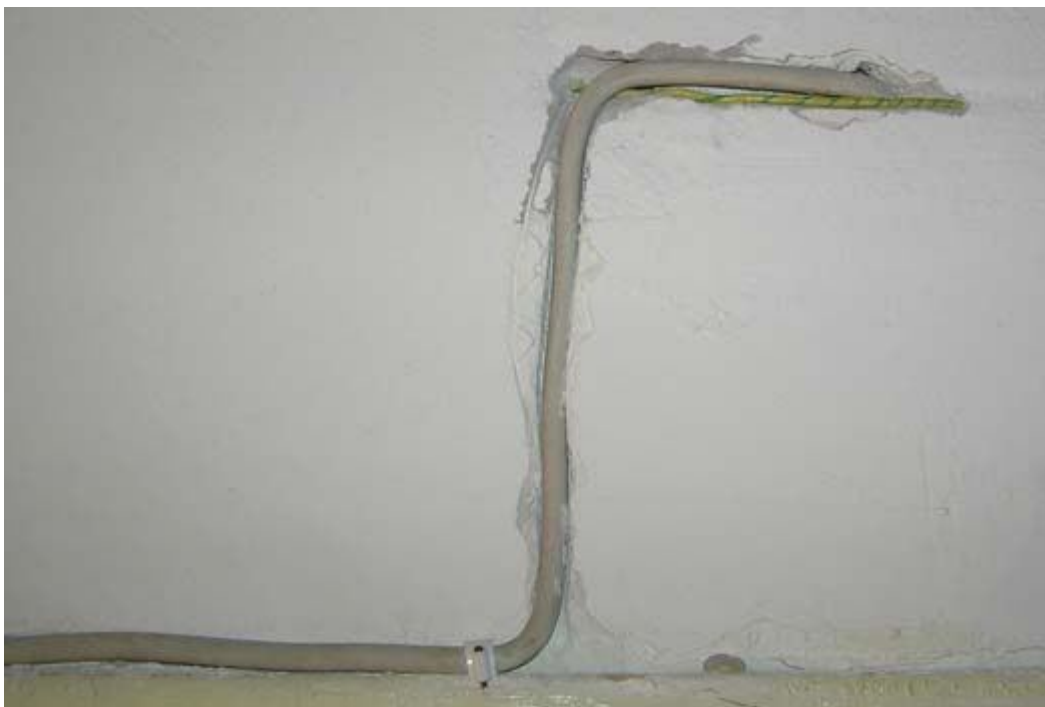
Рис. 1.40. Дополнительная (вручную) проводка заземляющего провода (штруба в стене)
