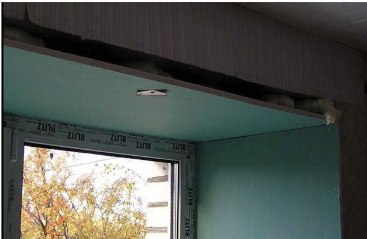
Рис. 1.49. Установка откосов в оконную нишу и фиксация листов гипсокартона саморезами
