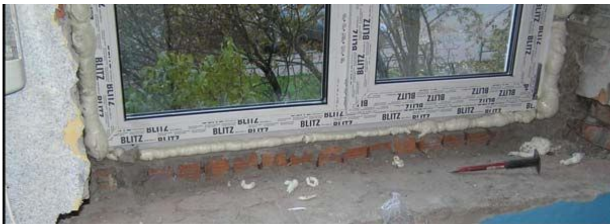
Рис. 1.48. Вид установленных рам и запененных ниш; промежуточный этап работ
