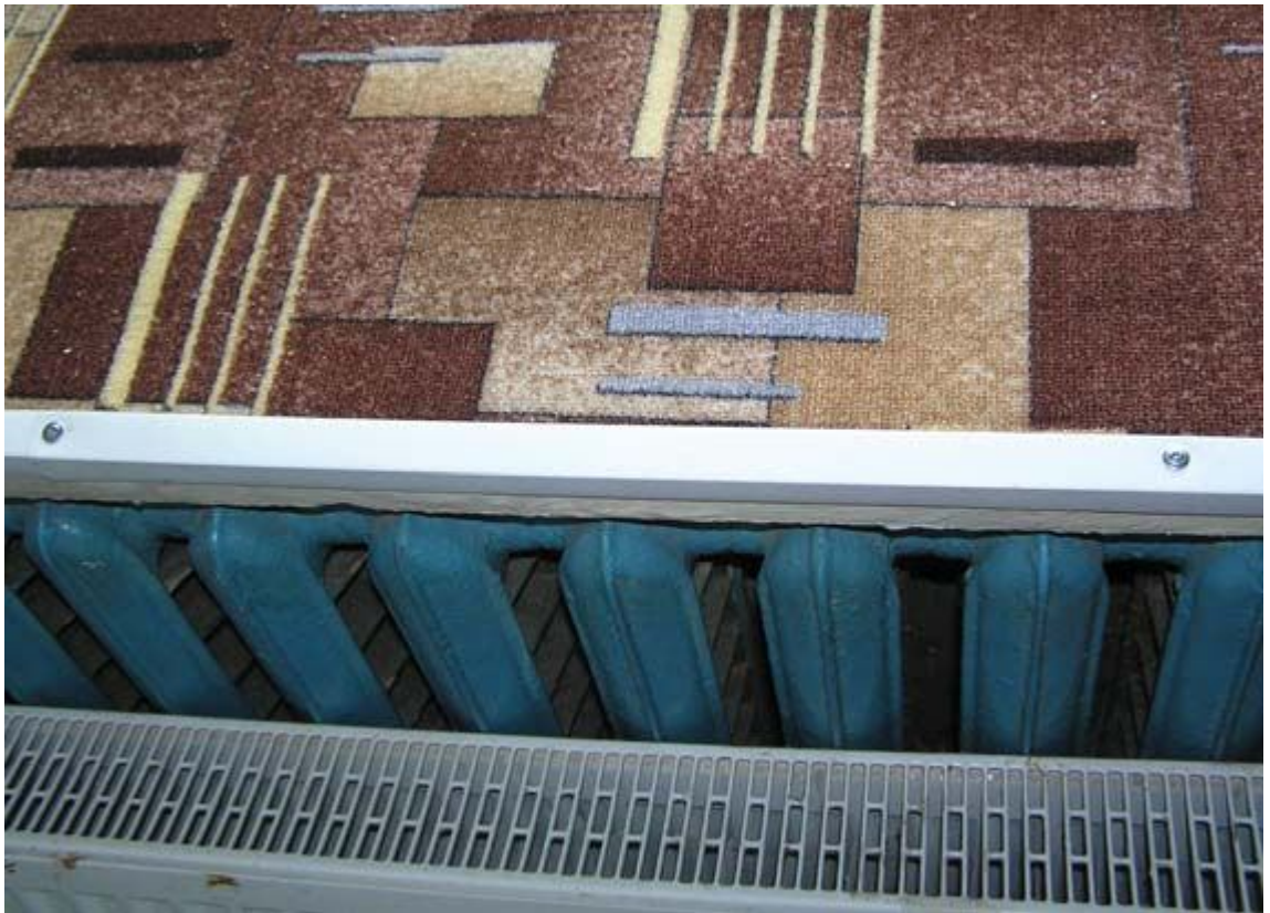
Рис. 1.17. Уголок предотвращает бахрому ковровина по краю подоконника
