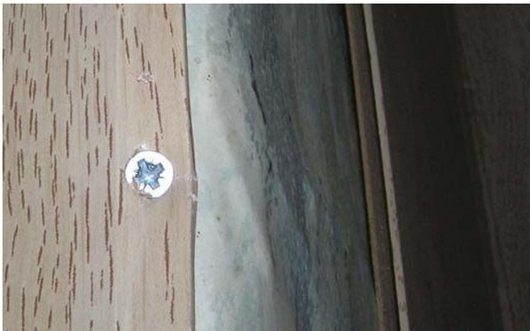
Рис. 1.31. Закрепление панелей за подошву саморезами
