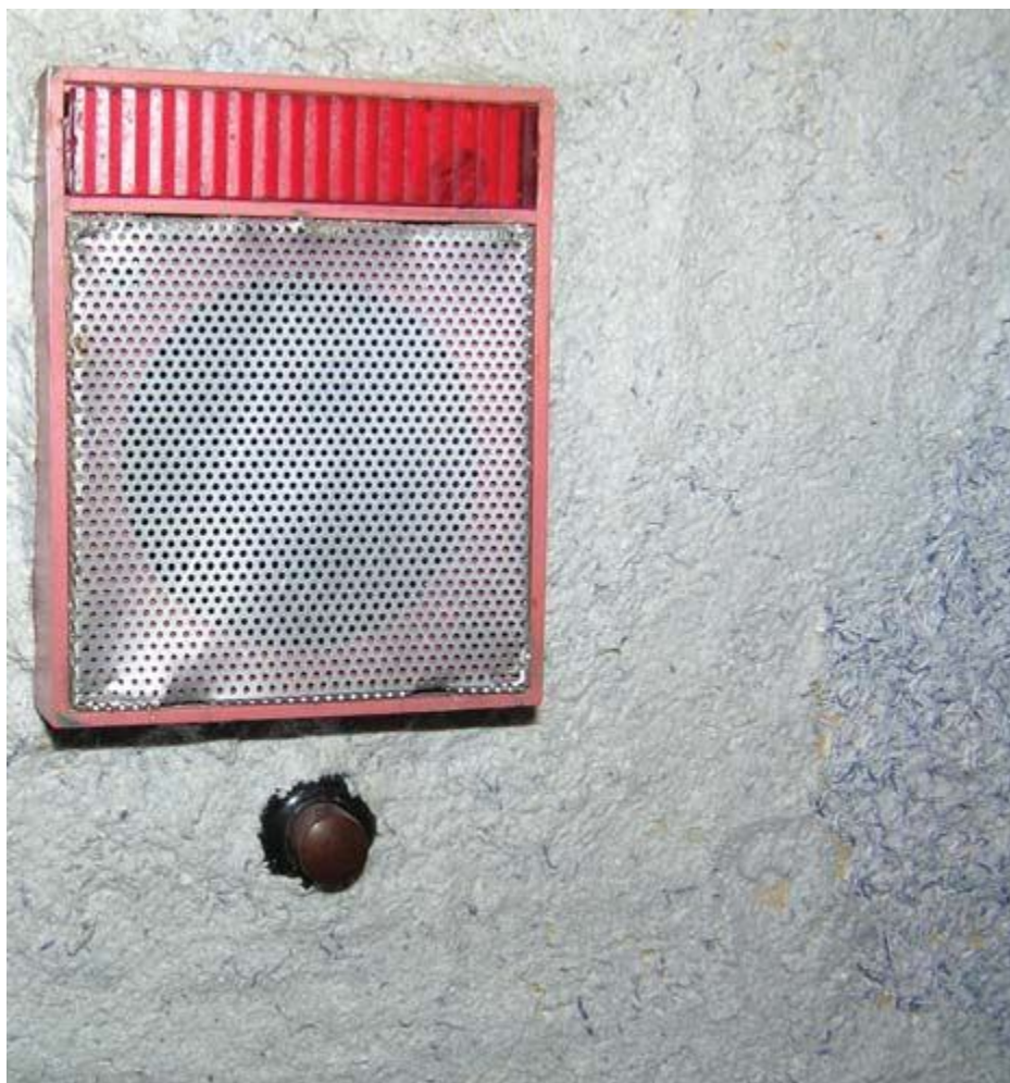
Рис. 1.10. Вид стены комнаты с подсохшими жидкими обоями
