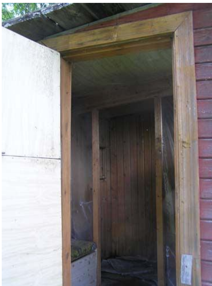
Рис. 2.8. Внутреннее строение душевой, разделение на помещения помывочной и предбанника
