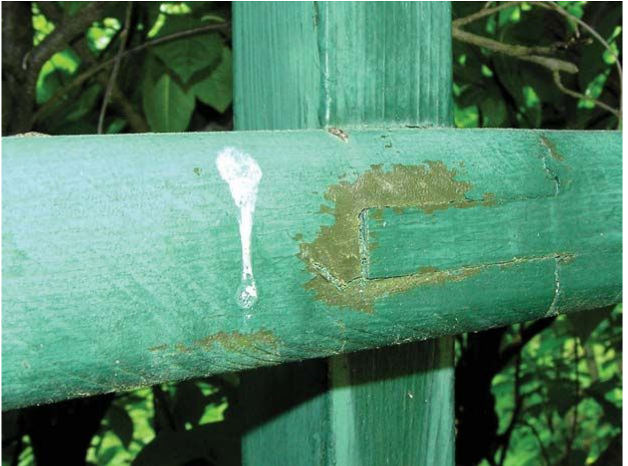
Рис. 2.21. Шиповое соединение
