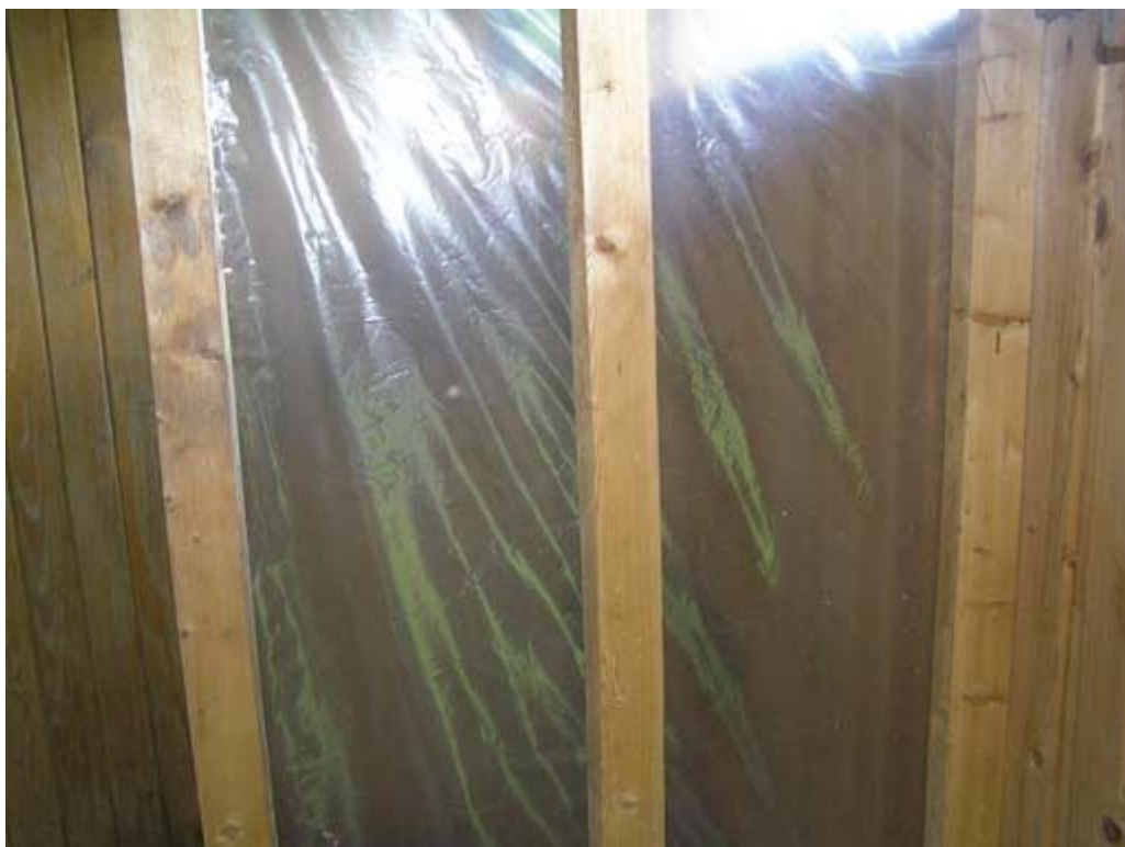
Рис. 2.9. Пленку натяните на деревянный каркас
