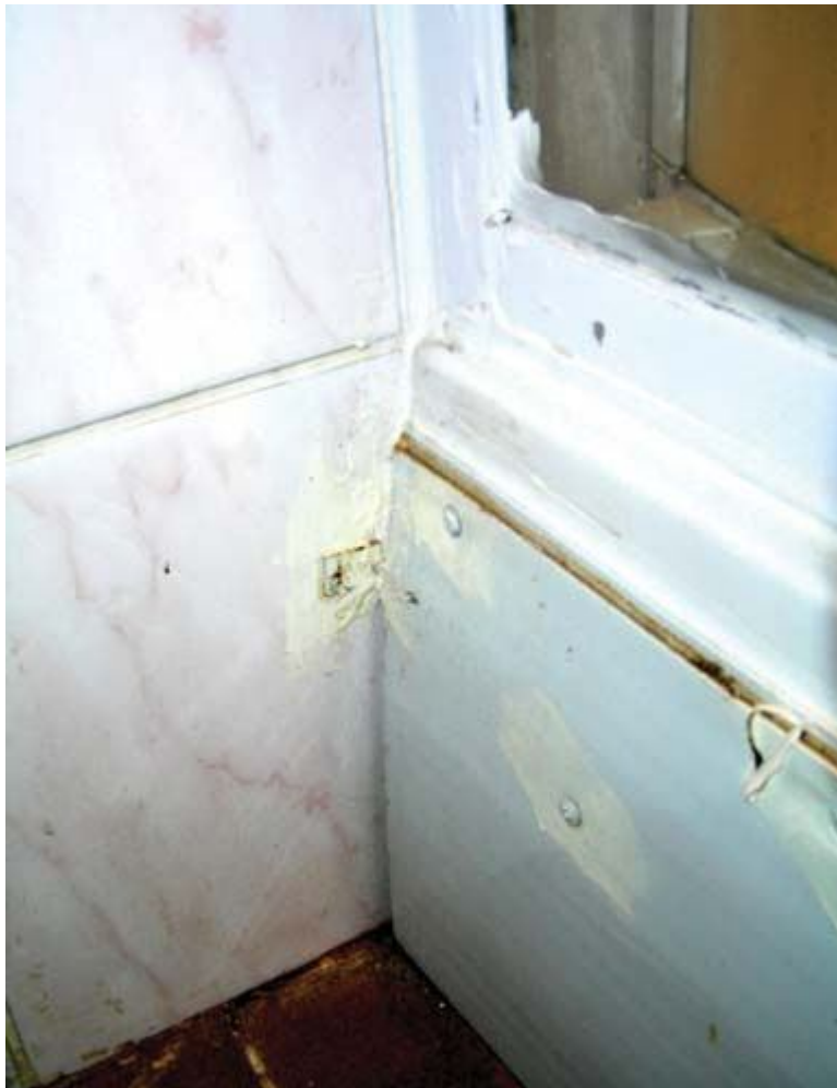
Рис. 1.12. Монтаж уголка по периметру кабинки
