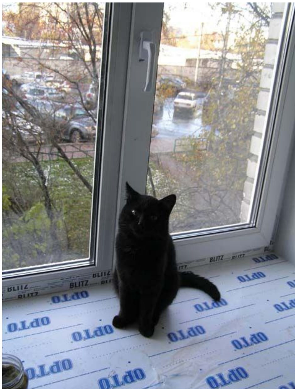
Рис. 1.54. Подоконник, покрытый защитной пленкой
