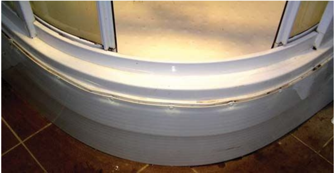
Рис. 1.13. Монтаж поддона душевой кабинки
