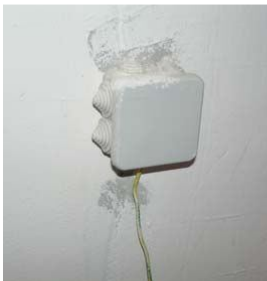
Рис. 1.39. Как проводить заземляющий провод
