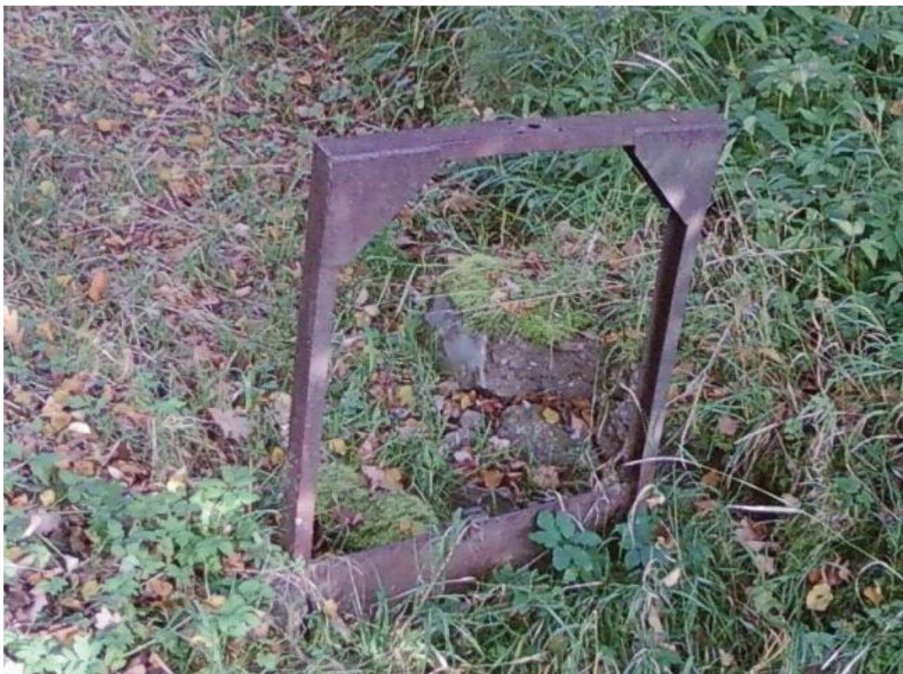
Рис. 2.15. Сварная скоба для настила досок для мостков
