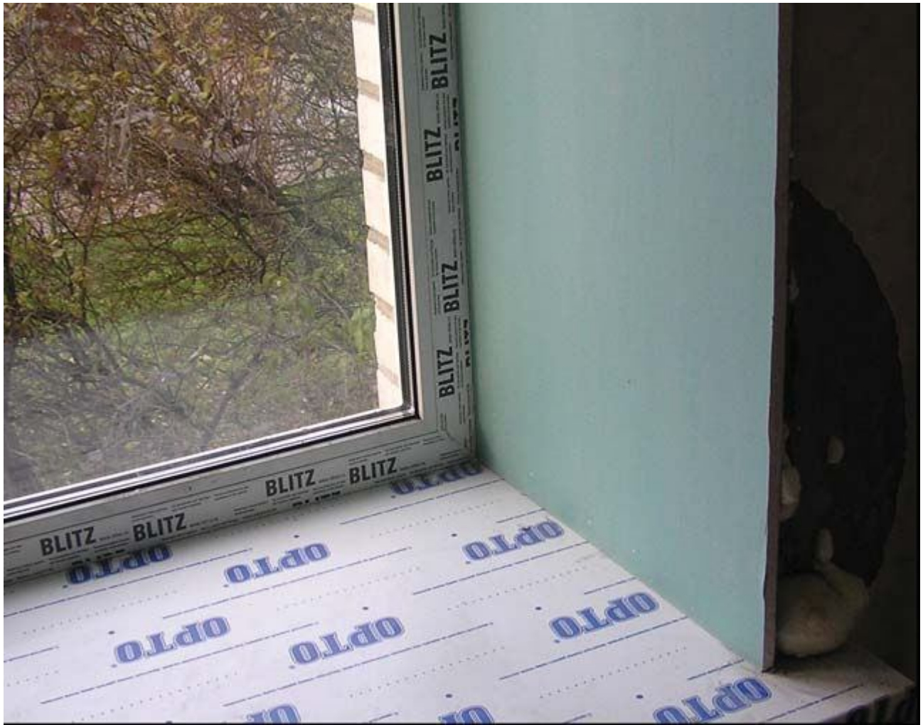
Рис. 1.50. Вид после установки и запенивания откосов
