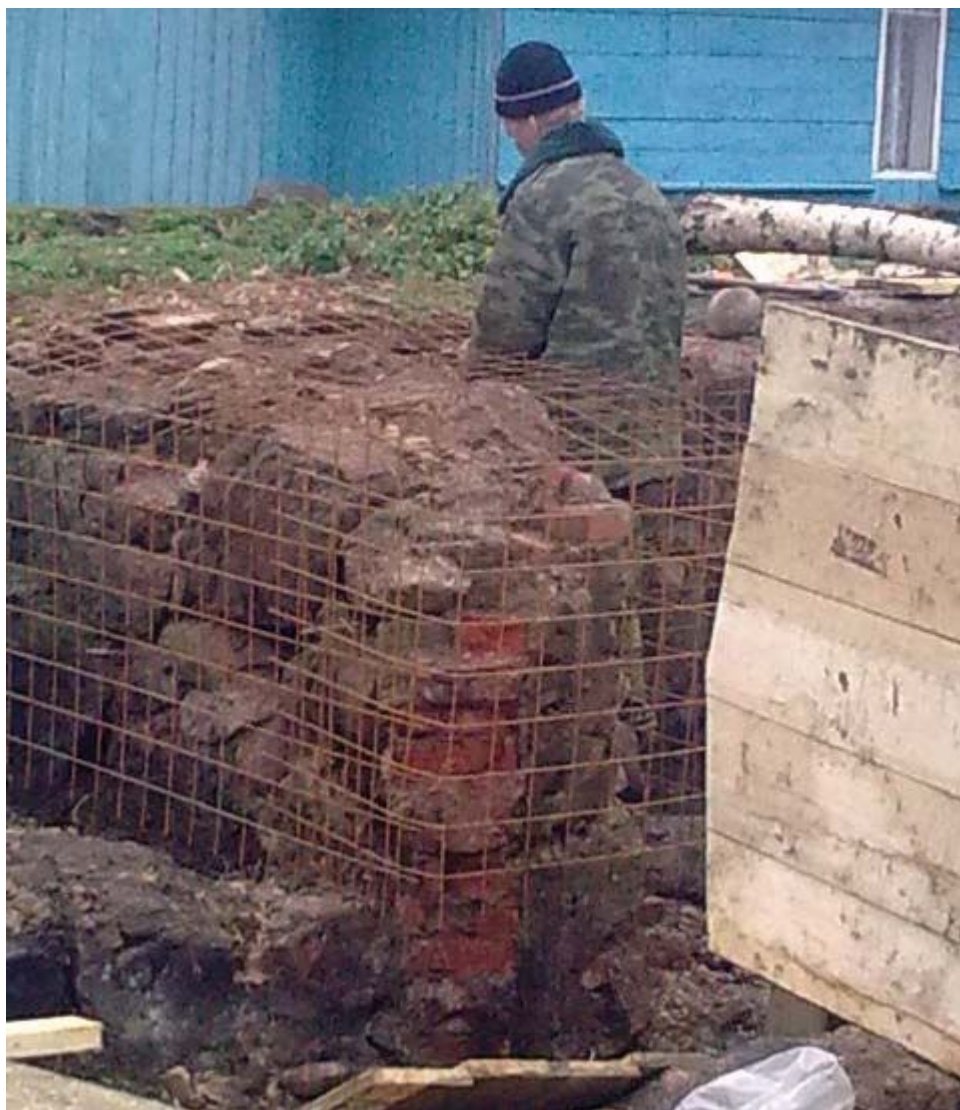
Рис. 3.7. Вид обтяжки старого каменного фундамента арматурной сеткой с толщиной прута 5 мм.
