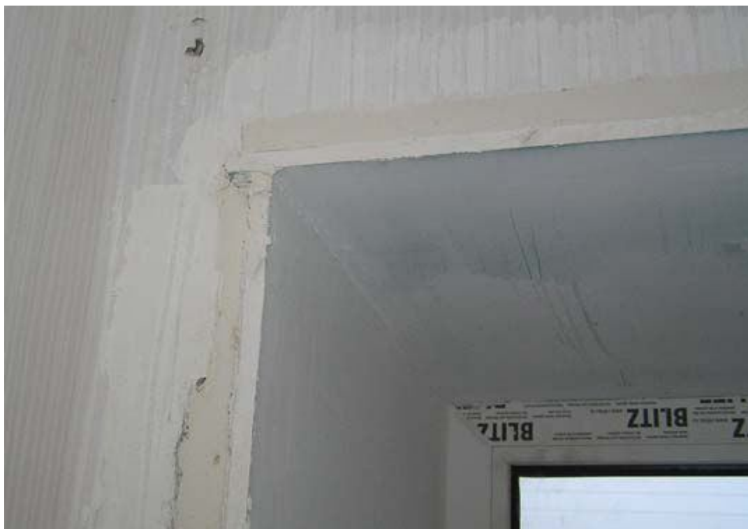
Рис. 1.51. Вид после цементирования и оштукатуривания откосов
