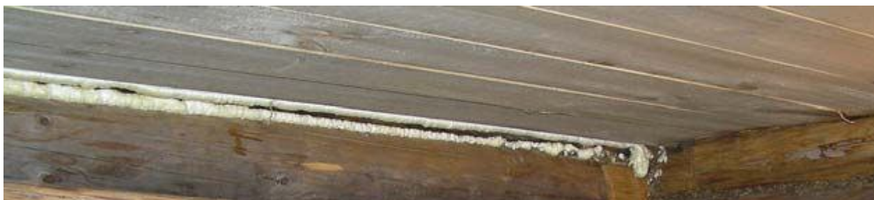
Рис. 2.2. Прокладка щелей и пазов
