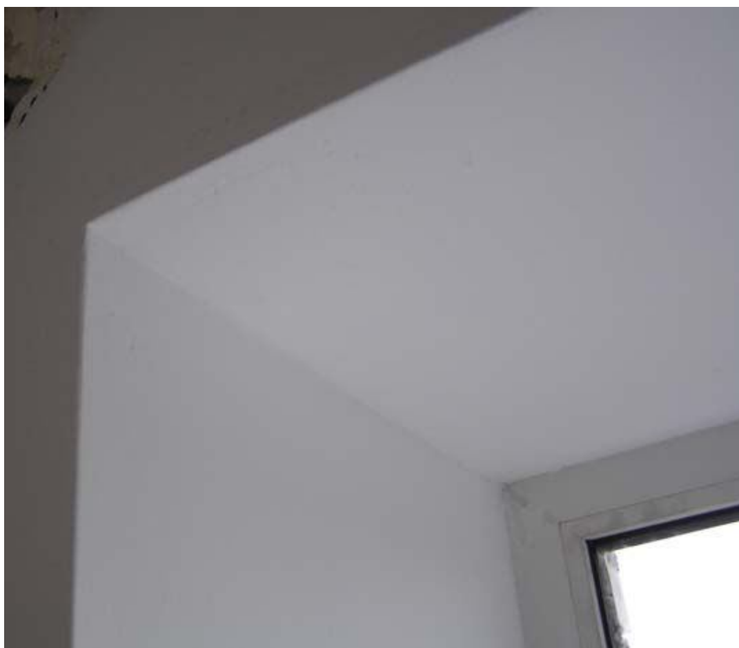
Рис. 1.53. Окончательный вид окна (тот же участок, что и рис. 10) после покраски
