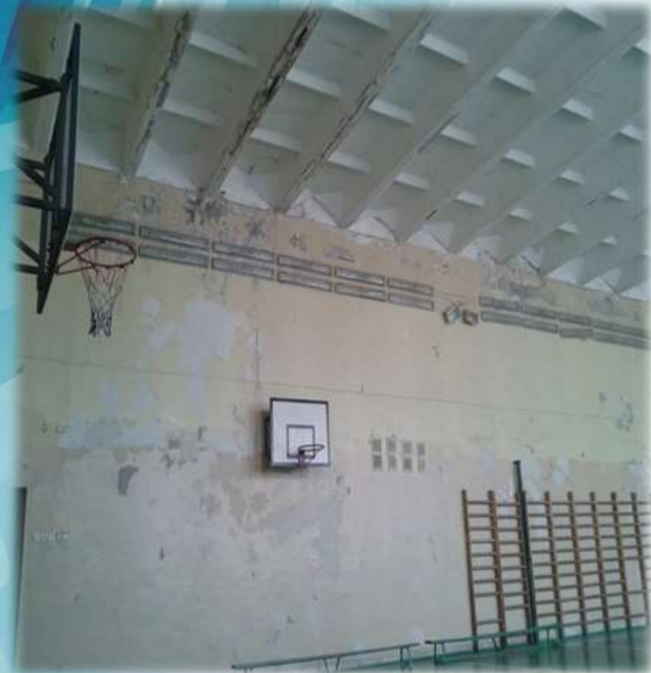
Большой спортзал до ремонта
