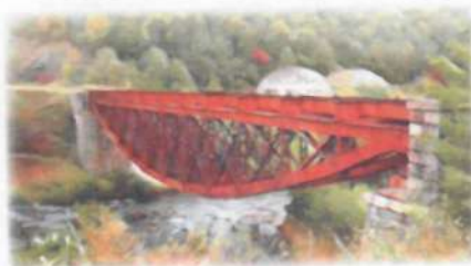
Шабартуйский комплекс — железный мост и железобетон- ный двухпролётный виадук
