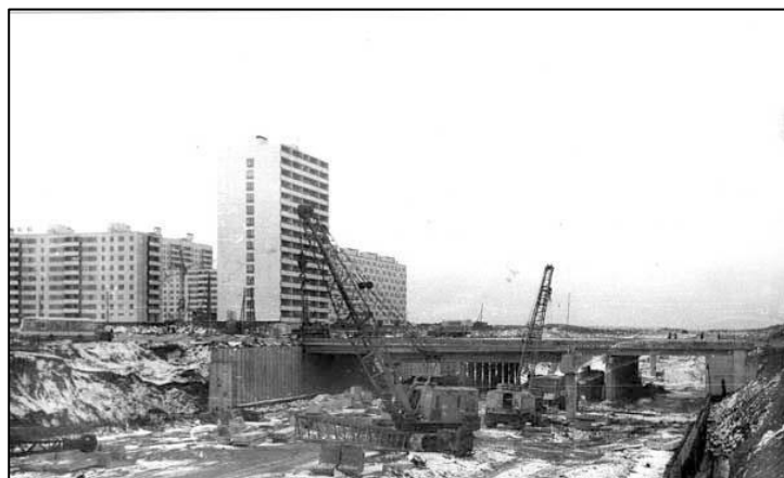
Рис. 3. Строительная площадка Нового города.
